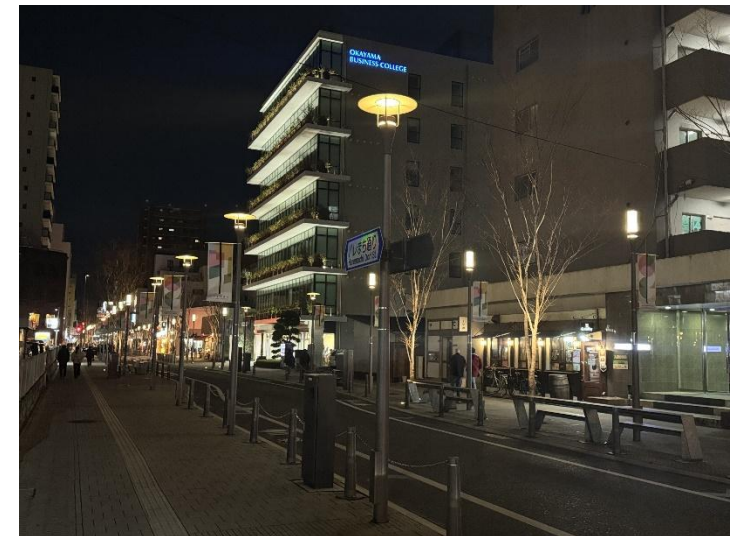
連続照明やアップライトによる夜間景観
