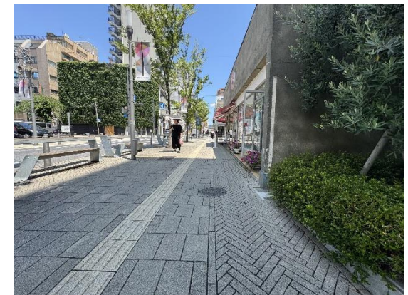
歩道空間の活用可能な箇所をヘリンボーン柄のインターロッキングブロックで整備
