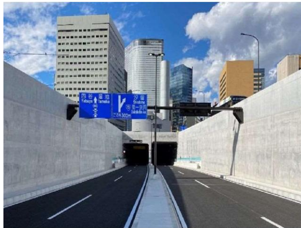
築地虎ノ門トンネル・築地側出入口の様子
