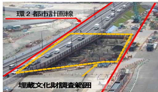
仮栈橋下での埋蔵文化財調査状況
