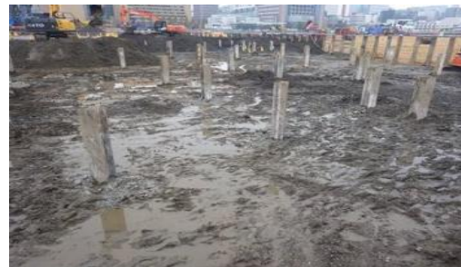
親杭横矢板とウェルポイント工法の実施状況
