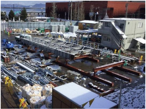
施工ヤード (青森駅東口駐車場・駐輪場)
