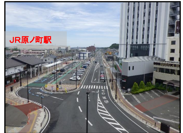
整備後(起点より)
