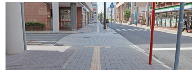
交差部では舗装の色調を変えて進入車両へ注意喚起
