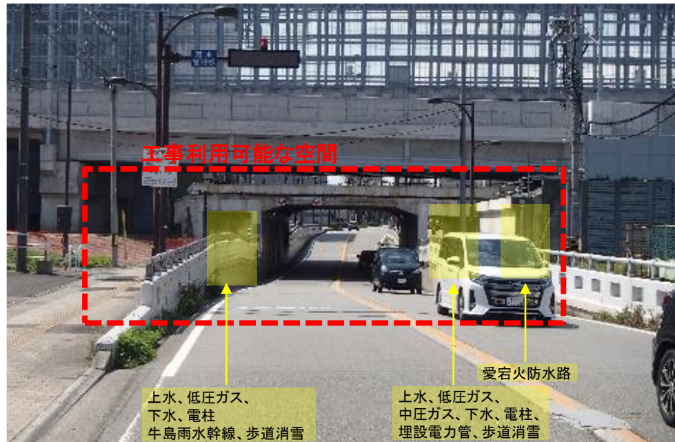
地下道撤去着手前の状況(R2.11)
