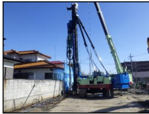
リーダ式ケーシング 回転掘削工法
