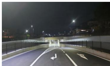
アンダーパス部夜間の状況 連続照明により明るさを確保
