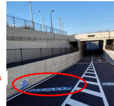
水深表示板を路面及び側壁に設置
