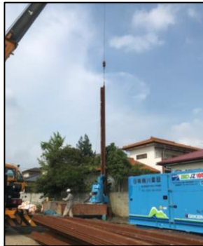
リーダ式ケーシング 回転掘削工法
