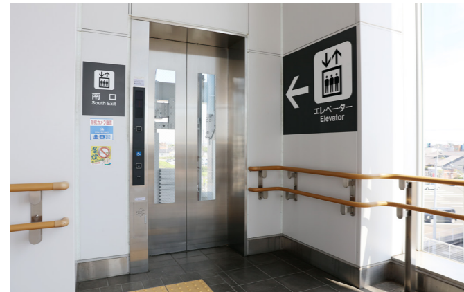
エレベーターの設置
