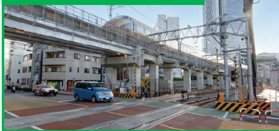
上り線高架切替後の状況（事業中）
