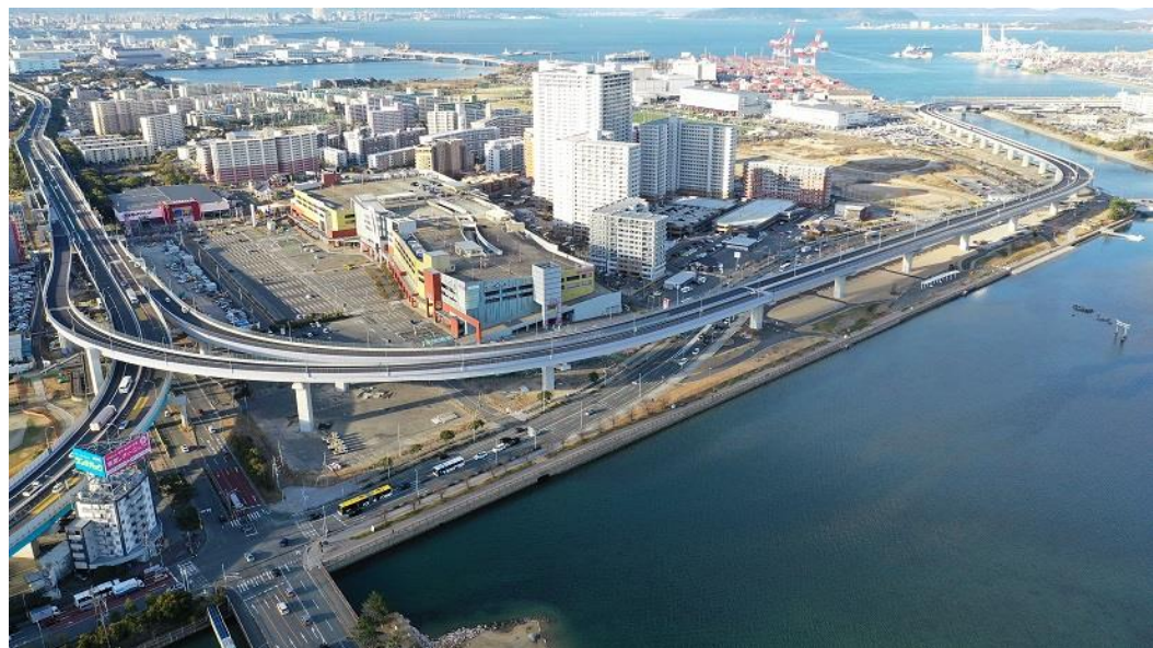
写真③ 全景 令和3年2月撮影
