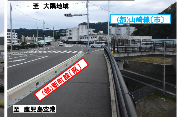
写真⑮ 橋梁交差及び交差点
