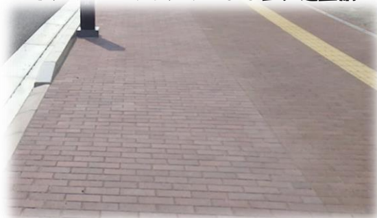
インターロッキングによる自歩道整備
