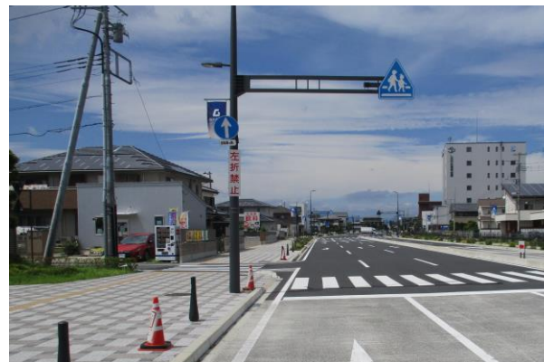
周辺住宅地への通り抜け防止対策
