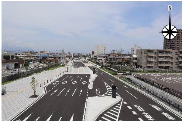
(都) コンベンション施設北口線 (Gメッセ群馬側から)
