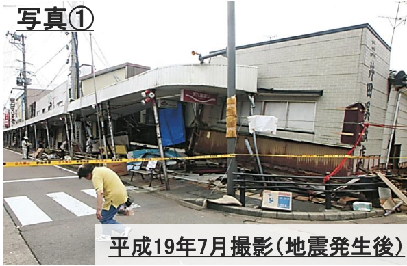
1F部分が 倒壊した店舗と 傾いたアーケード
