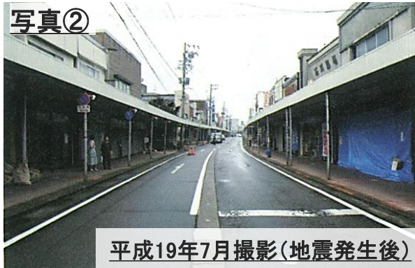
平成19年7月撮影(地震発生後)
