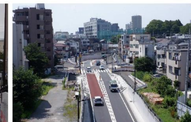
補助第26号線(豊町)交通開放後の様子 ＜JR線交差点付近から平塚橋交差点方向を望む＞
