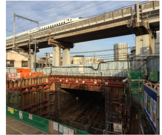
【ふたばトンネル施工状況】
