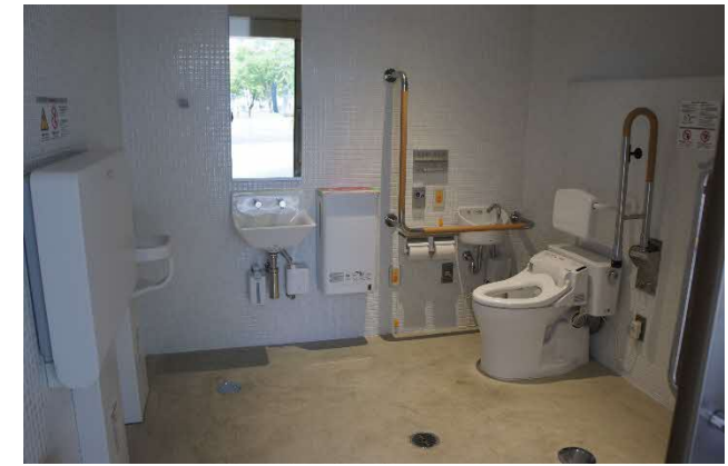
整備後の多目的トイレの内装
