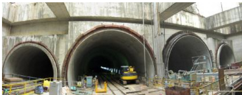
大阪府シールドトンネル施工状況（超近接4連併設トンネル）
