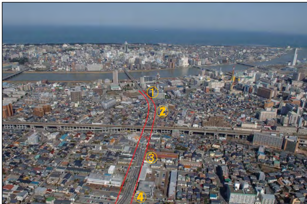
南から北を望む(用地買収前のため 計画法線上に多数の民家がある)
