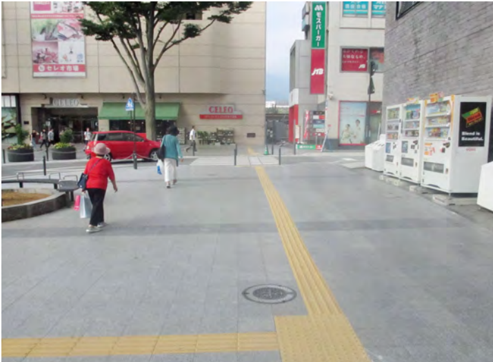
整備後 | 違法駐輪がなくなり、歩道の通行が快適になった。
