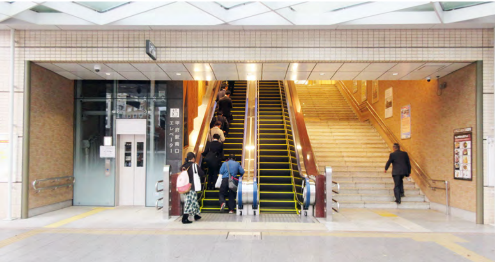
駅にも斜行式エレベーターを設置
