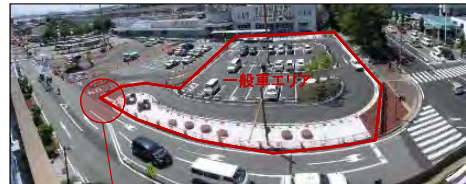
一般車エリア工事完了時
