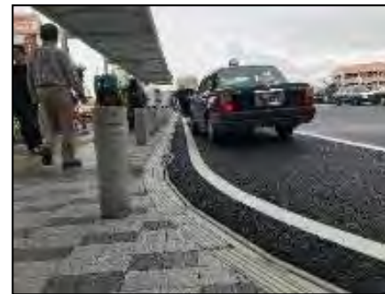
◀ タクシー乗降場の段差のない歩車道境界ブロックと排水性舗装（一般乗降場も同様）
