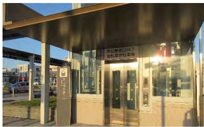
地下通路から駅広へアクセスしやすいエレベーター
