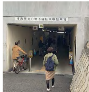
道路を横断する地下通路
