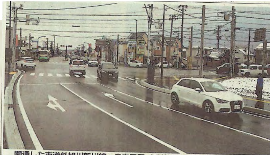
開通した市道外旭川新川線・寺内工区(手前)。野村交差点で新国道と接続し、直進方向には外旭川アンパスがある=25日午前7時20分ごろ
