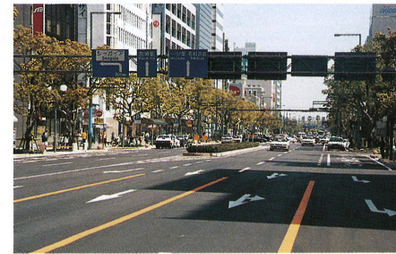
右折レーン、バスベイを設置
