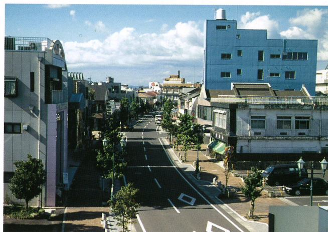
煉瓦造りの歩道と電線類の地中化による景観整備
