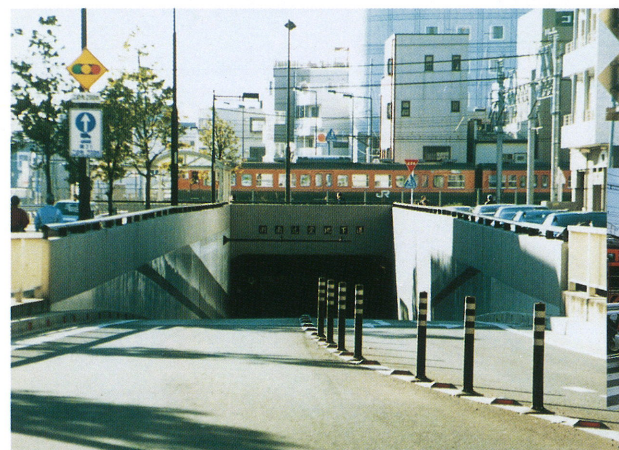
整備後(羽鳥立体)
