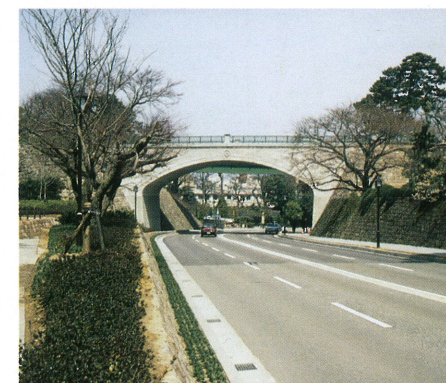
旧石川橋全景
