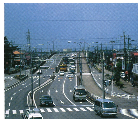
西川田跨線橋 (東武宇都宮線立体交差)
