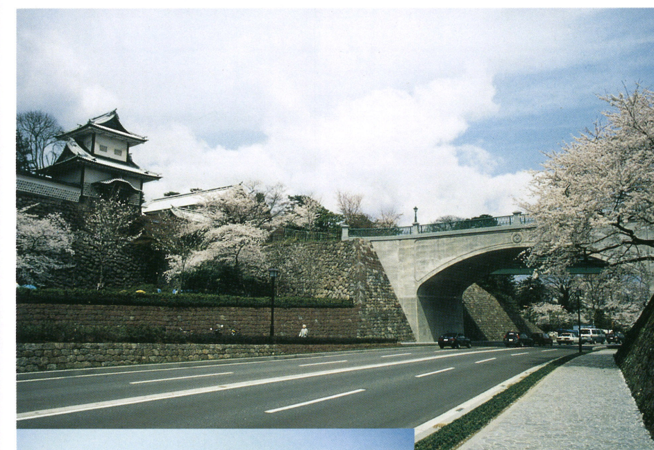
旧石川橋のデザインを継承した新石川橋全景
