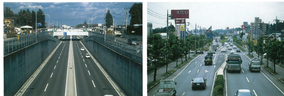
下砥上アンダー (JR日光線・県道羽生田鶴田線立体交差) 宇都宮市駒生町付近
