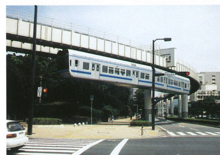
JR京葉線と接続する千葉みなと付近
