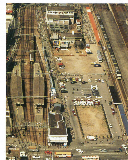
整備前 (左側の山陽電鉄線を右側のJR山陽本線の隣に移設)
