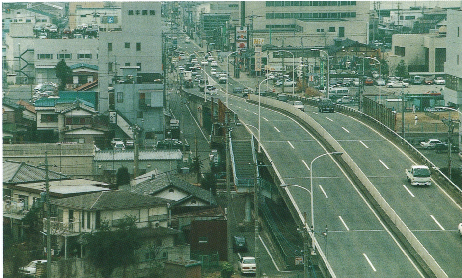
JR上越線との立体交差（昭和48年度完成）
