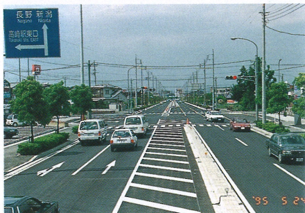
環状線最終工区となった地区（平成7年3月完成）
