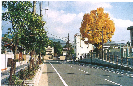
町のシンボルのイチョウを残した道路整備
