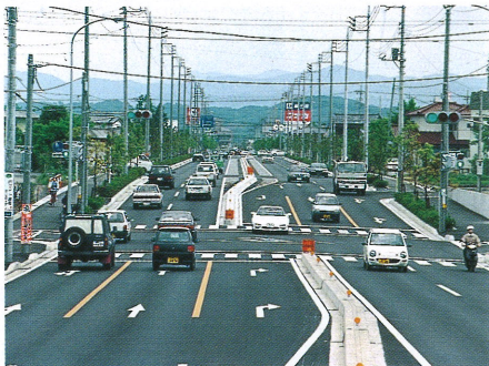
環状線の完成後、新住宅街が形成された地区（昭和59年度完成）
