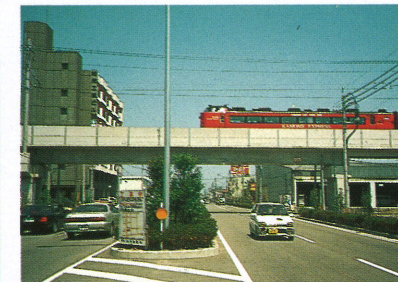
立体交差された市道一ツ葉通線
