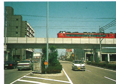
立体交差された市道一ツ葉通線
