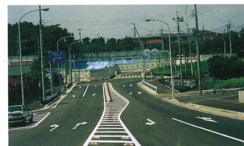
周辺環境と調和した道路空間
