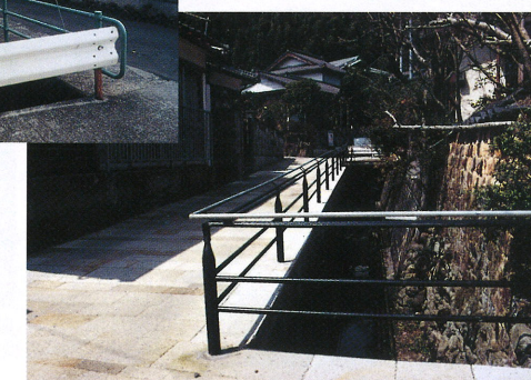
景観に調和した河川の手摺り（整備後）
