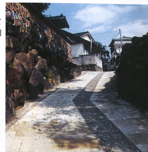
自然石によるきめ細かいデザインを施したみちと排水溝の整備
