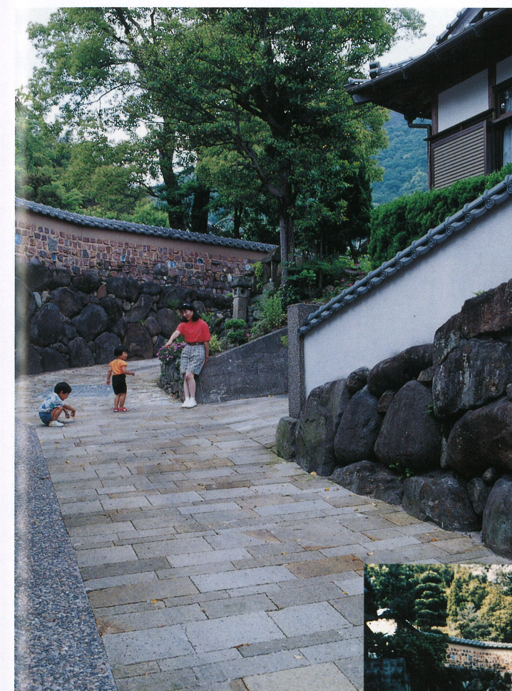
起点側全景（整備後）
