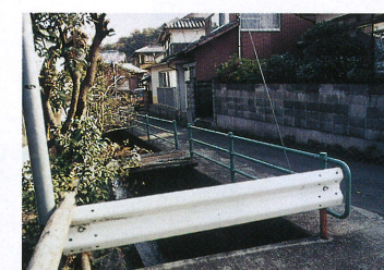
整備前のガードレール
