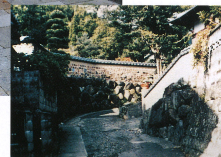
起点側全景（整備前）
