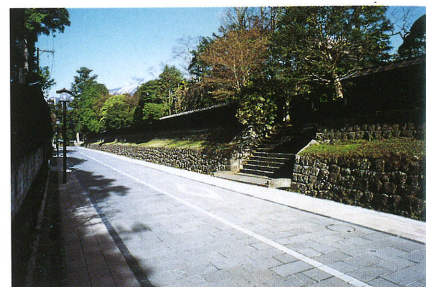
冬期のスリップ防止も兼ねるミカゲ石の舗装
