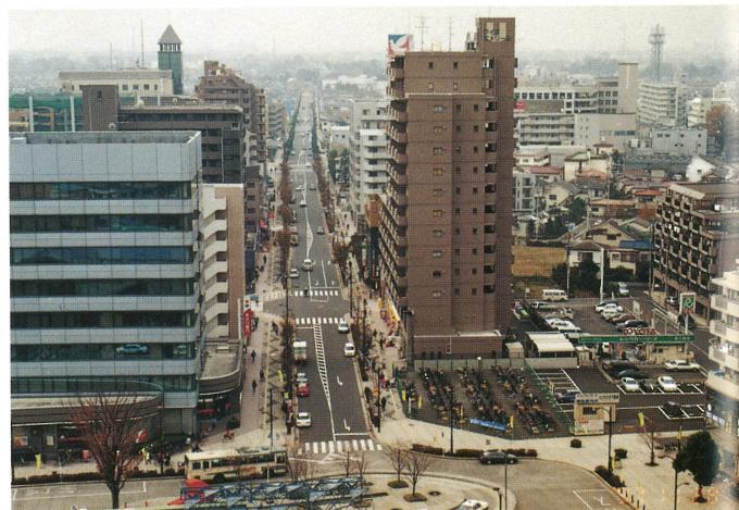
駅西口広場からのびるシンボルロード（まろにえ富士見通り）
