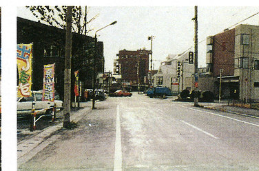
中間より起点側を望む（整備前）
