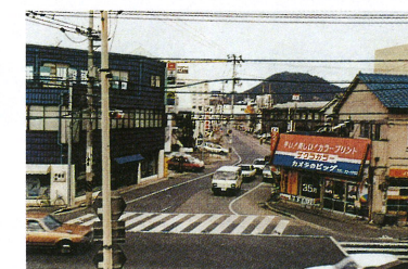
起点より中間点を望む（整備前）
