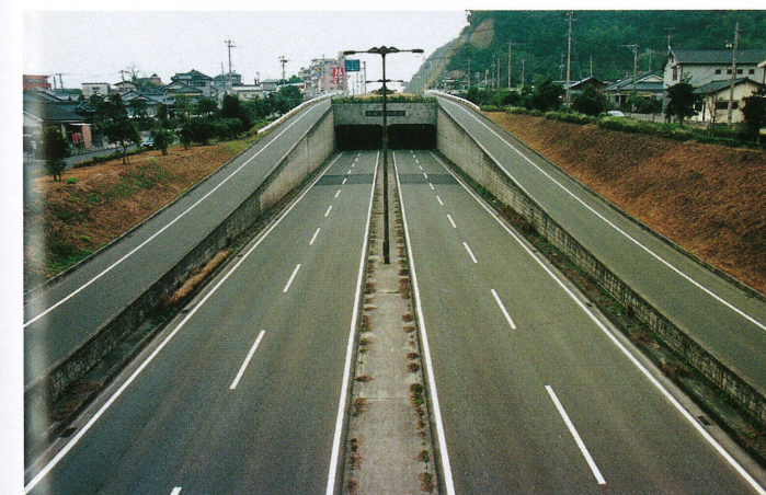
中間点より終点側を望む
