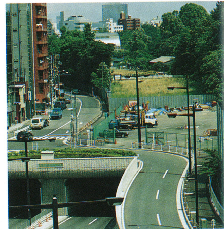
新宿側坑口付近（新宿から御苑方向を望む）
