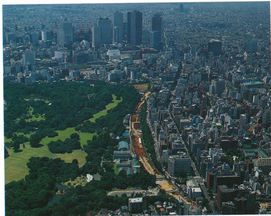
新宿御苑トンネル（四谷側坑口上空）
