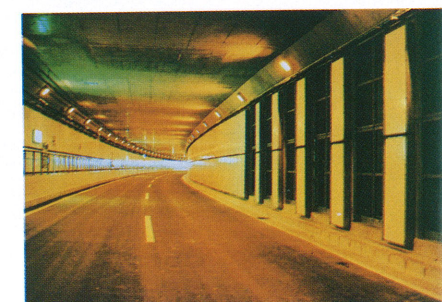
トンネル内部
