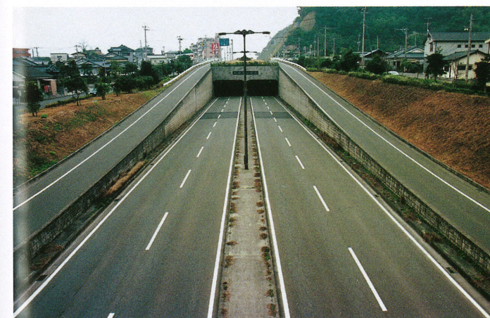
中間点より終点側を望む
