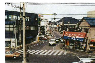
起点より中間点を望む（整備前）
