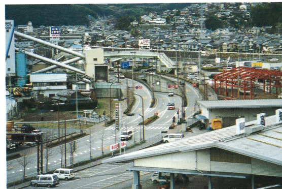
国道33号立体交差部
