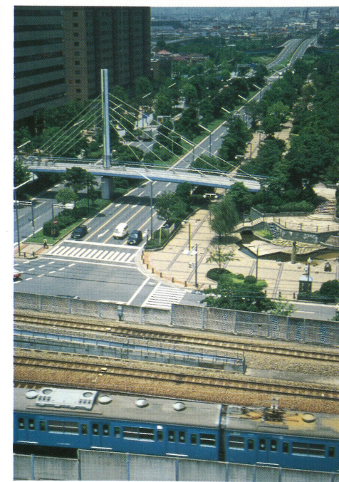
シンボルロードに架かる歩道橋
