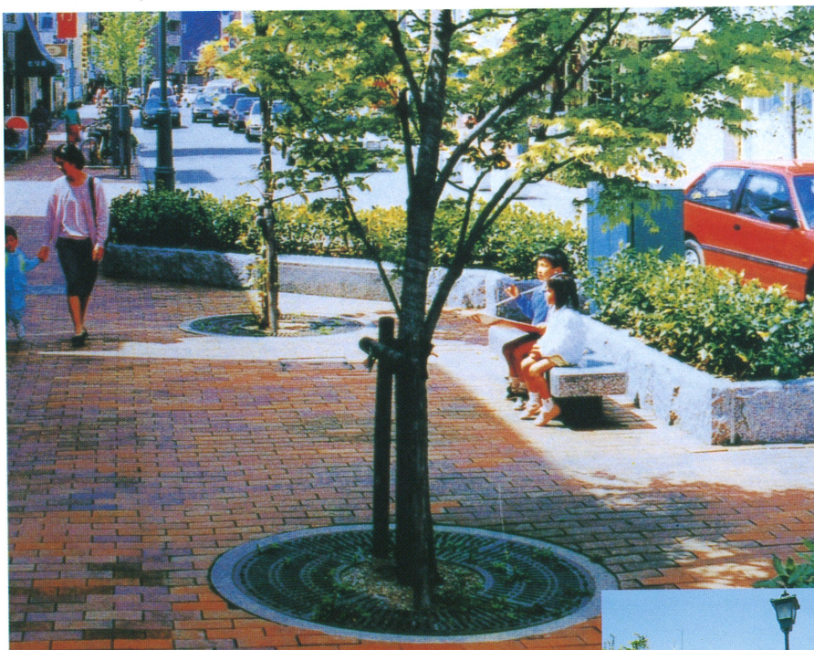
ボンネルフ方式で整備された歩道
