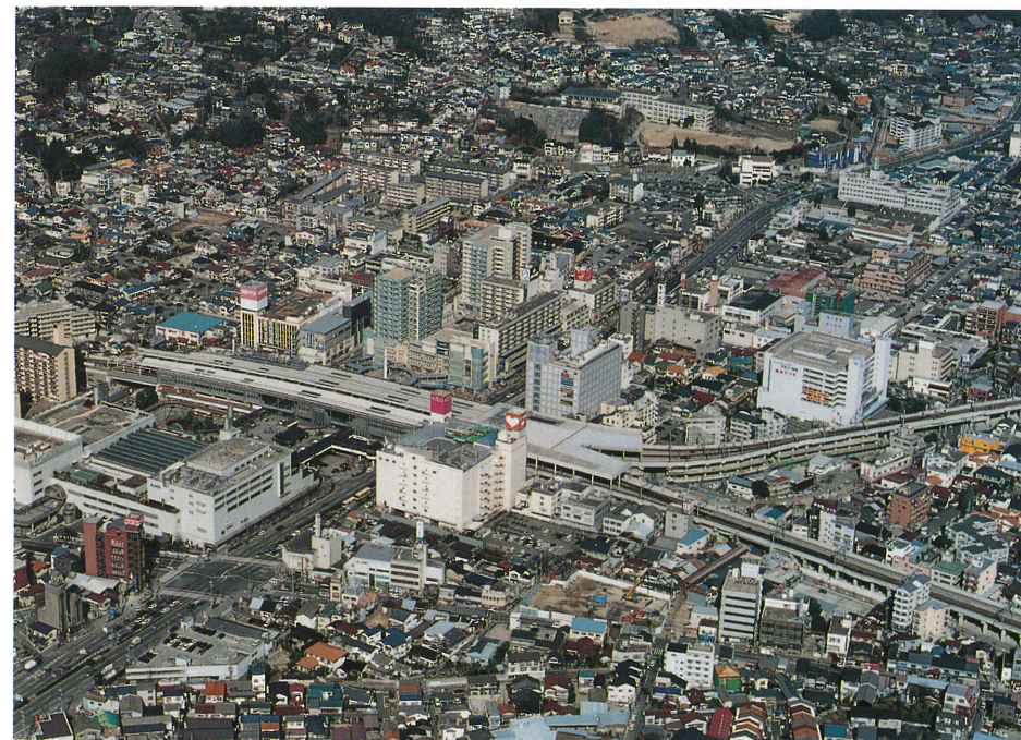
川西市能勢口駅と駅前広場、さらに北部住宅地へ伸びる川西猪名川線を望む
