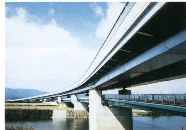
羽束師橋（上：車道橋、下：歩道橋）
