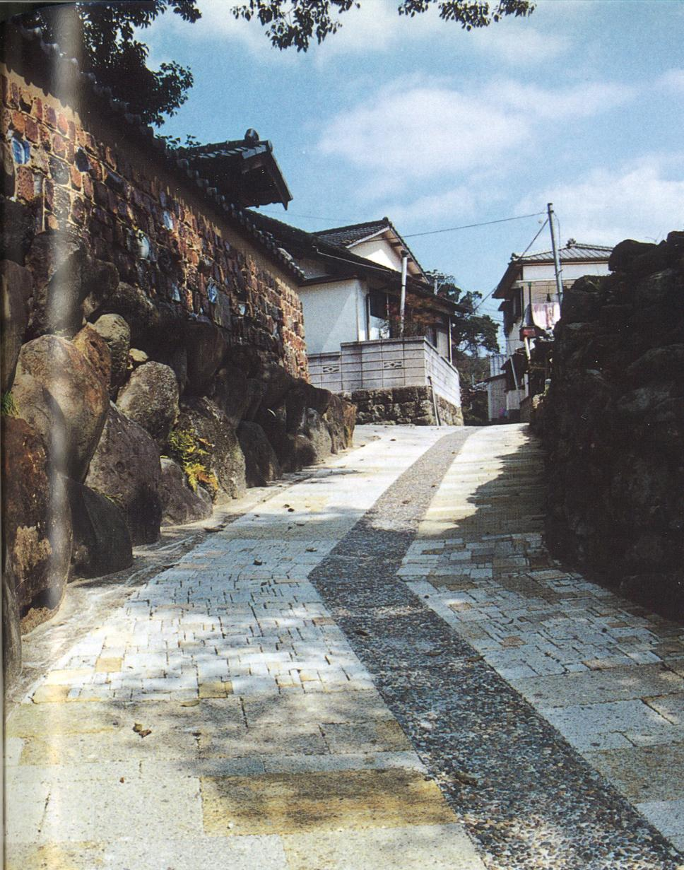
自然的景観と歴史的雰囲気をもしだすべく自然石によるきめ細かいデザインと排水溝の整備を行なっている。
