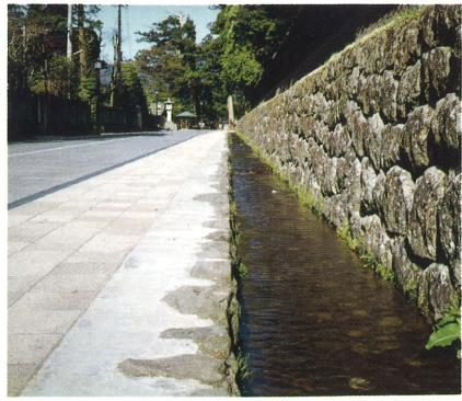
水路の底を栗石の亀張りとし、日光の清流をイメージしたせせらぎとし、路面はミカゲ石張り舗装とした。
