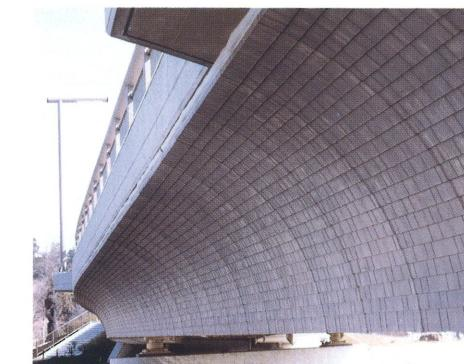
アルミ製桁化粧。好文亭の屋根に使われている桧葺き模様をデザインした。表面は塗装処理。
