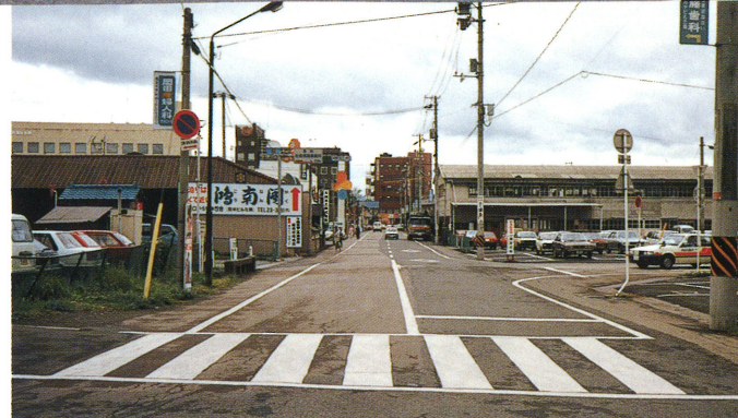
起点側から終点側を望む。歩道もなく、人と車が幅轢している。
