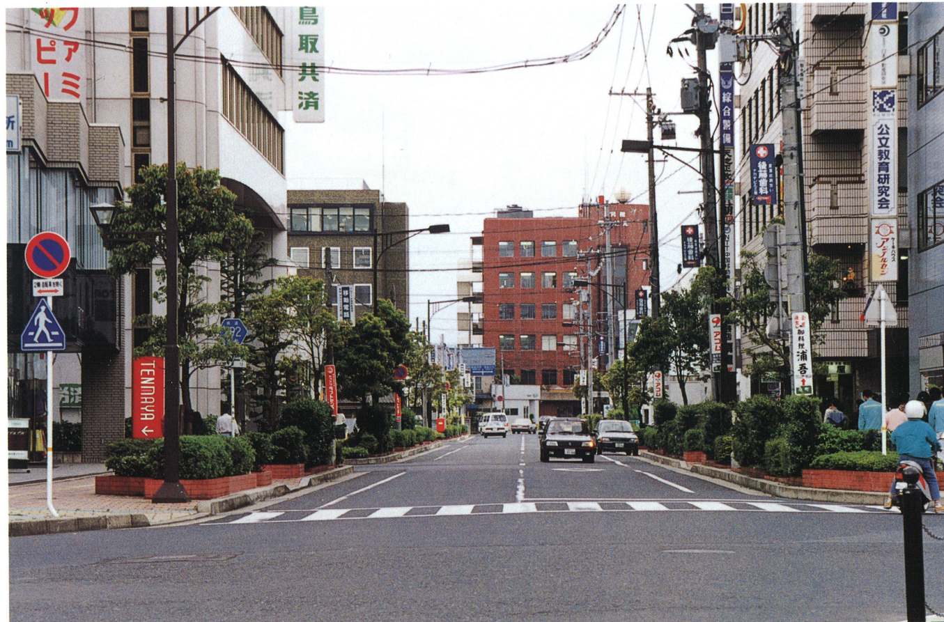
起点側から終点側を望む。人と車が、重厚な植樹帯により分離され、安全性が向上した。
