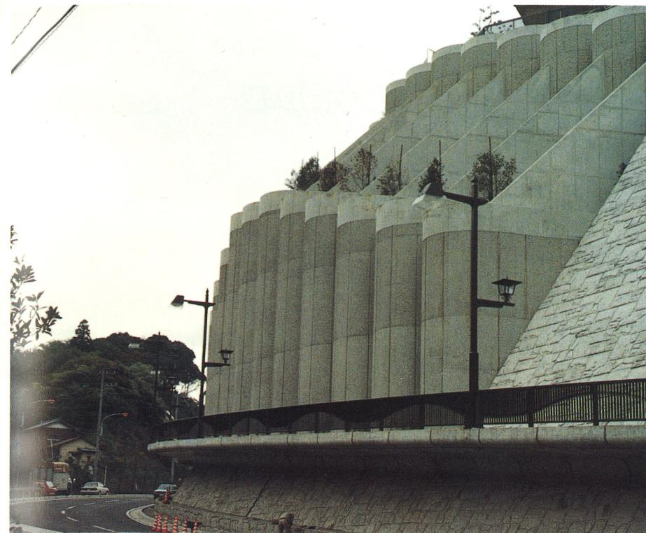
道路幅員を確保するため歩道を張り出し構造とし、また円形型枠を用いることにより構造物の威圧感を和らげている。
