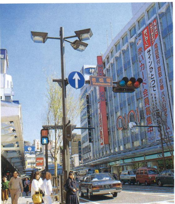
信号共架型照明／道路景観向上のため、地中化工事とあわせて、照明信号、規制標識等の柱類を一本化し、地上施設の整流統合を行なっている。柱の足もとにステンレスリングを採用したり、大きな張紙防止シートを巻きつける等の工夫も行ない、シンプルでおしゃれな照明となっている。
