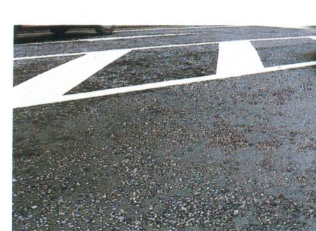
車道特殊舗装(改良明色舗装)／2種類のカラーチップ骨材を舗装表面に機械を使って敷きならべ、特定の色彩を出すという初の試みを行なっている。アスファルト合材も全く新しく開発し、使用した。いわば個性的なみちづくりに合わせたオーダーメードの舗装である。
