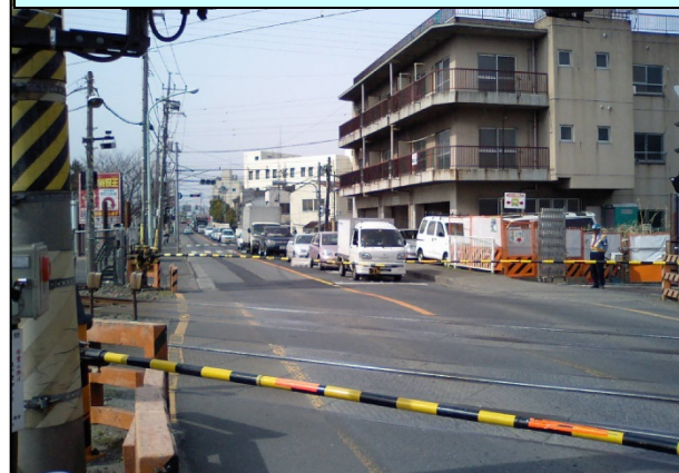
大丸踏切 (旧府中街道)
