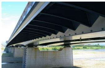
美しい2点支承の主桁と橋脚の納まり
