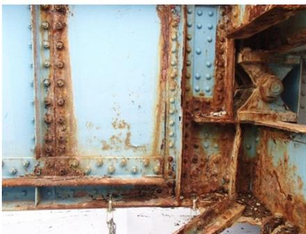
桁の腐食が著しい状況
