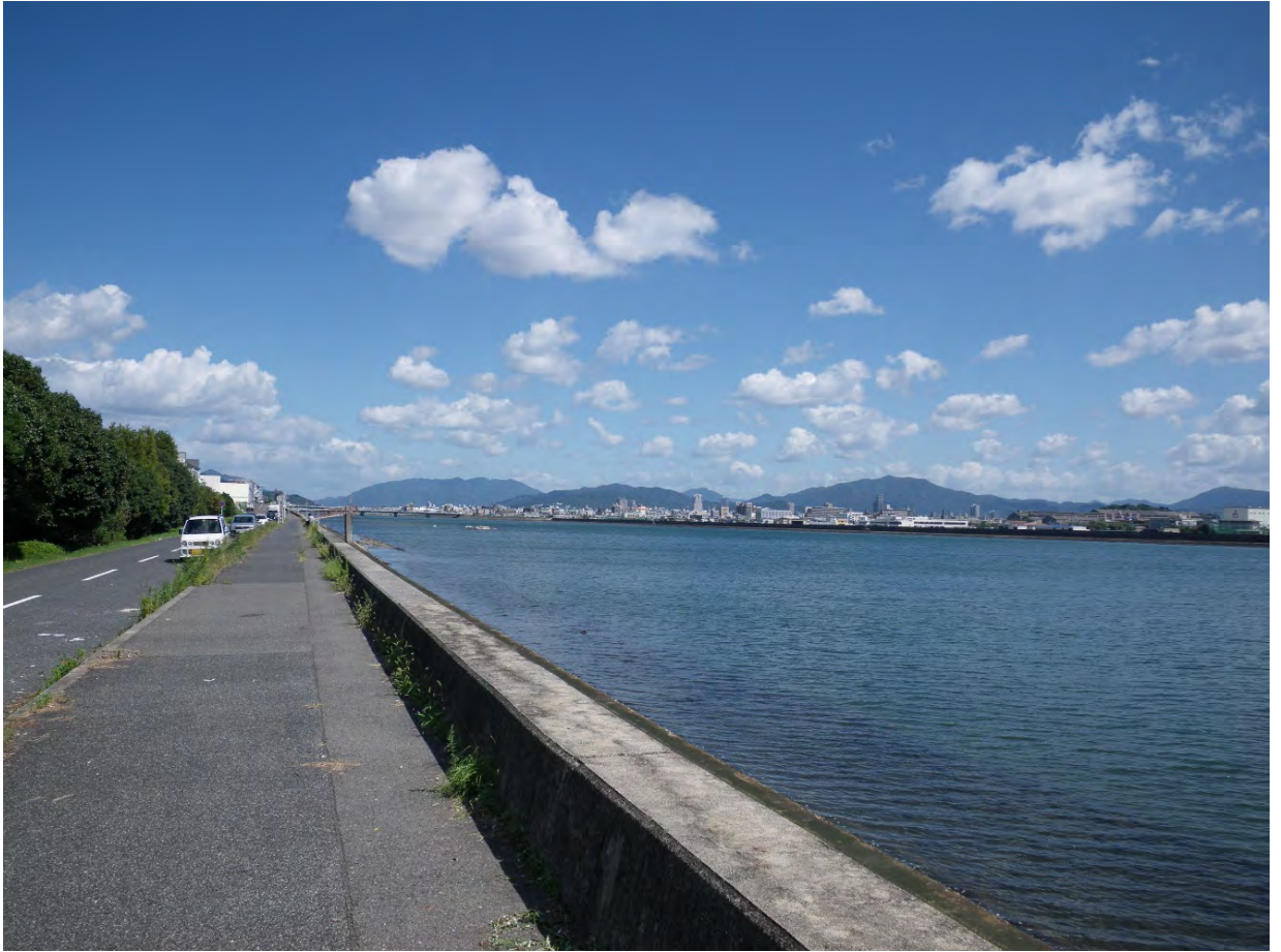
太田川放水路右岸 下流側より上流側を撮影
